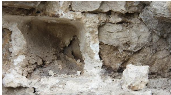
Mauerwerk mit historischem Gipsmörtel
