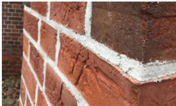
Instandsetzung mit tubag Gipsmörtel
